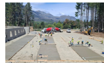
Central de incendios, BLS
