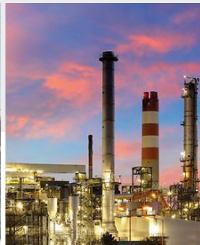
AUTOMATIZACIÓN Y CONTROL
