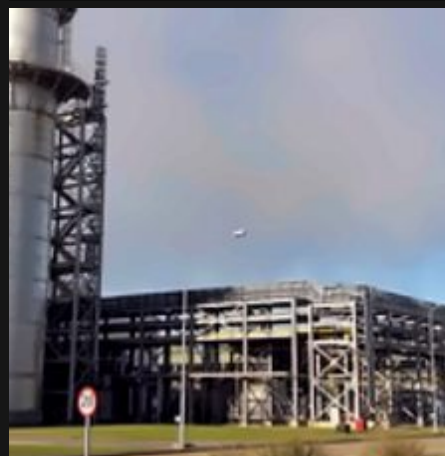
CENTRAL TERMOELÉCTRICA Campana, Buenos Aires
