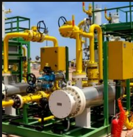
GASODUCTO CARDALES Buenos Aires
