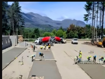
CENTRAL DE INCENDIOS Bariloche, Río Negro
